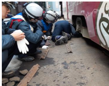
復旧機材の設置手順を確認する車両係員
