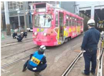
脱線復旧の指示を行う作業指揮者
