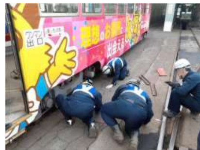
ベテラン職員から脱線復旧のレクチャーを受ける
