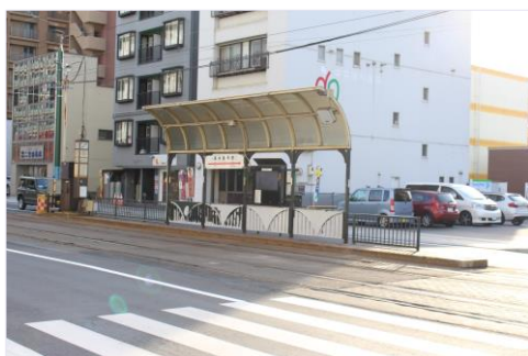
東本願寺前停留場（内回り）改修前
