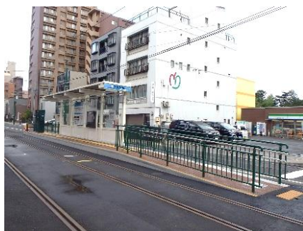
東本願寺前停留場（内回り）改修後
