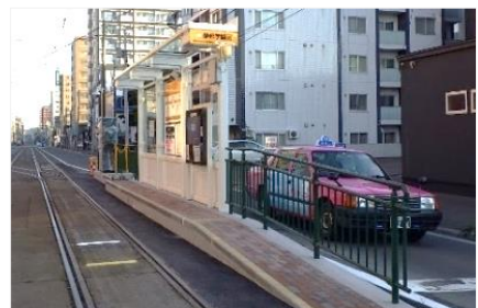
改修後の外回り停留場
