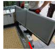
大通駅 止水板
